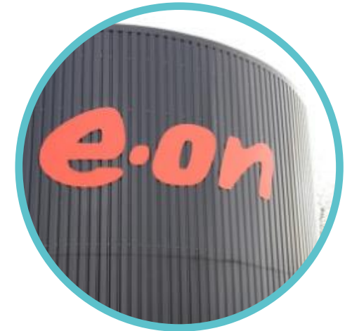
Akkumuleringstank giver 10-20 timers varmforsyning
